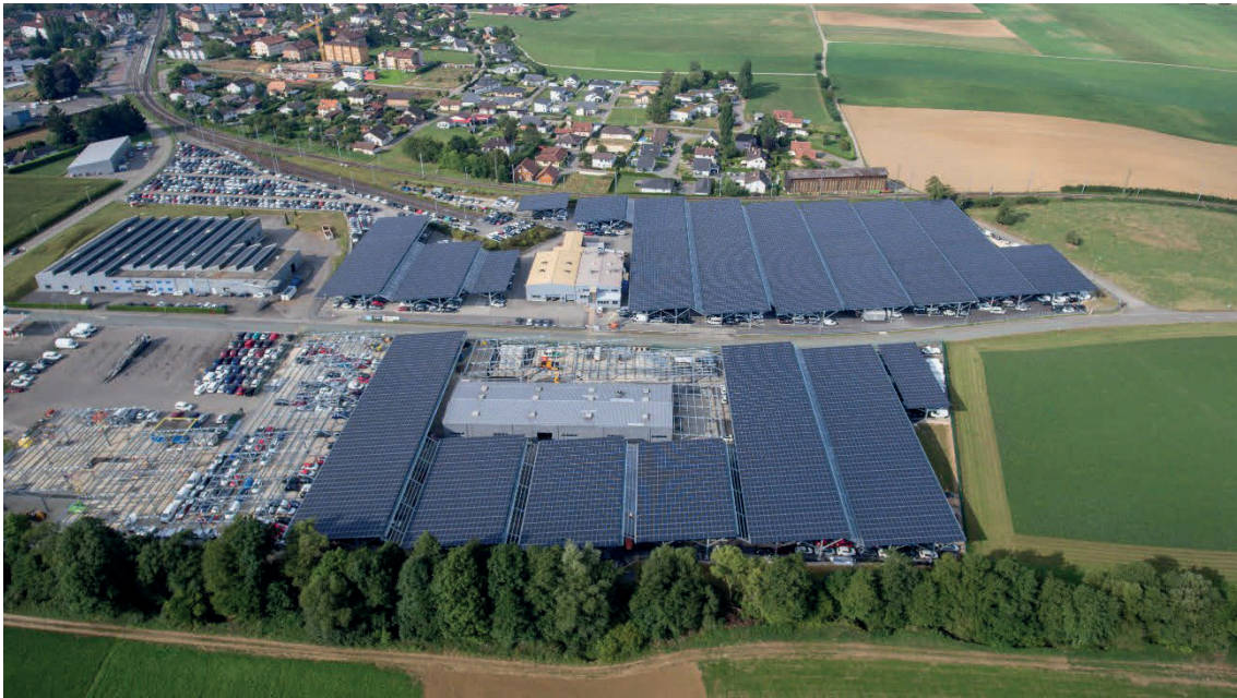
Abb. 4: Solaranlage als Überdachung eines Grossparkplatzes in Courgenay (Teil der Anlage). Quelle: https://www.edj.ch/domaines-daction/energies-renouvelables/nos-realizations.html
